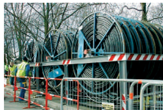
Pose des fourreaux où vont pouvoir circuler les câbles optiques.
